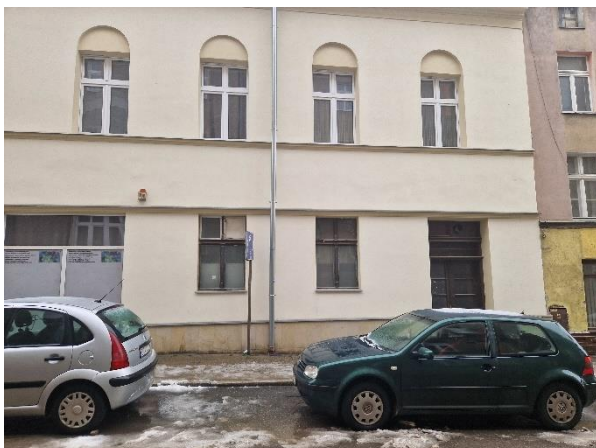
Zdjęcie 3 Widok budynku
