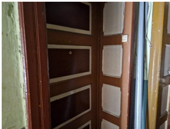
Zdjęcie 6 Wejście do lokalu
